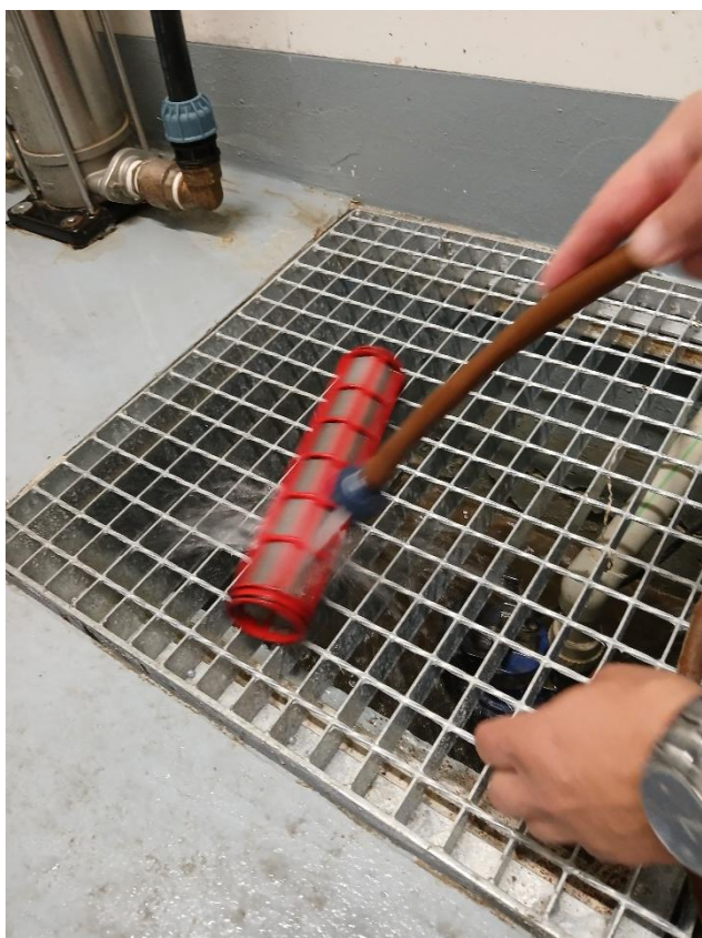
Obr. 4: čištění filtru závlahového systému
