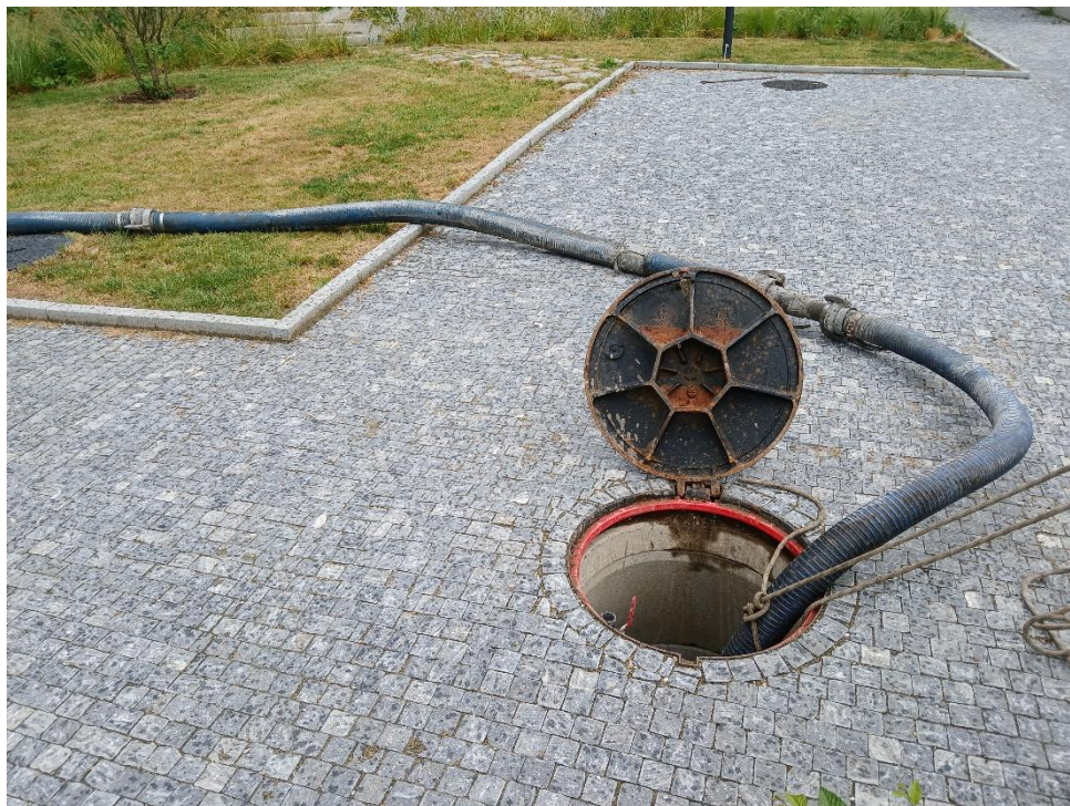
Obr. 1: odsátí a čištění retenční nádrže
