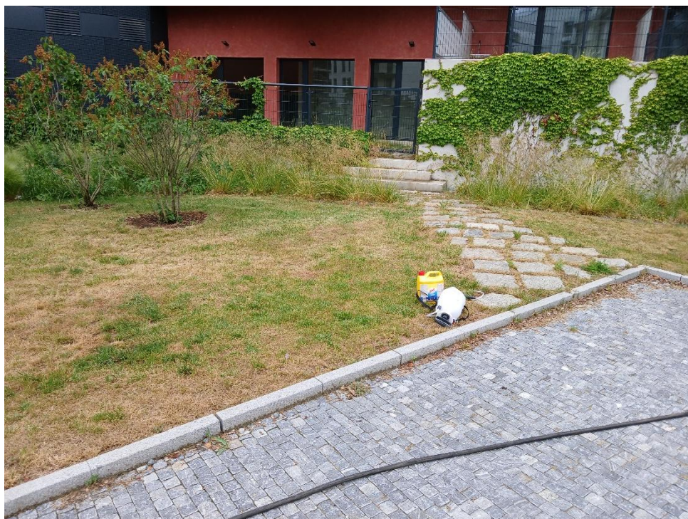
Obr. 2: dezinfekce retenční nádrže naředěným roztokem SAVO
